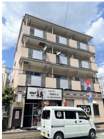
[外観・現況][現況外観写真]
