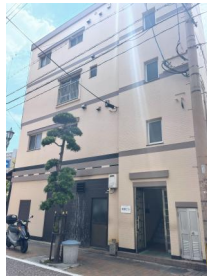
[外観・現況][現況外観写真]
