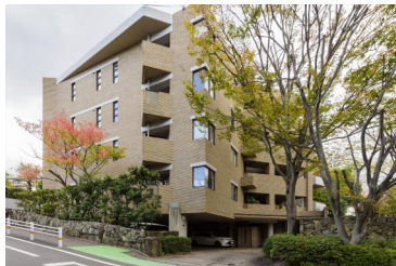
[外観・現況][外観写真]
