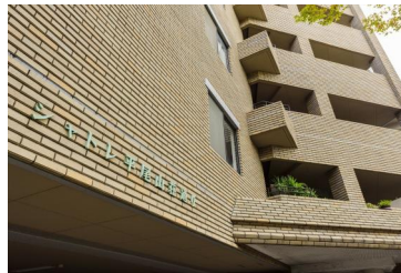
[外観・現況][外観写真]
