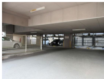
[共用部・設備施設][駐車場]
