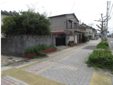
[外観・現況][前面道路含む現地写真]
