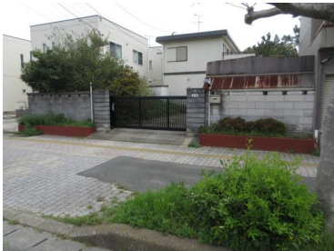
[外観・現況][前面道路含む現地写真]
