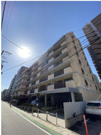
[外観・現況][外観写真]クリームカラー&ライトグレーの差し色でデザインしています。
