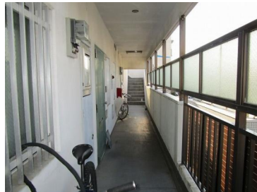
[共用部・設備施設][その他共用部]
