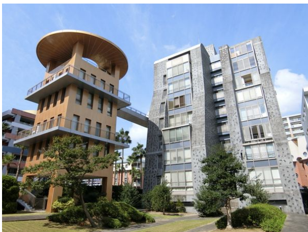
[外観・現況][外観写真]
