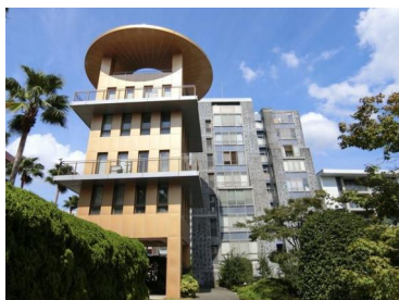
[外観・現況][外観写真]
