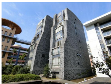
[外観・現況][外観写真]
