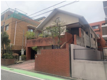
〔外観・現況〕〔現況外観写真〕
