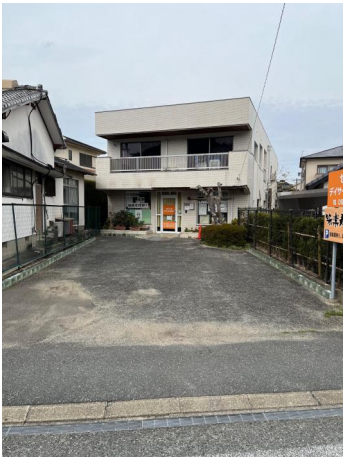
[外観・現況][現況写真]
